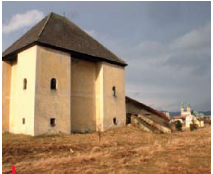
Do tej stacji krzeszowskiej Drogi Krzyżowej wiodą tzw. święte schody.
